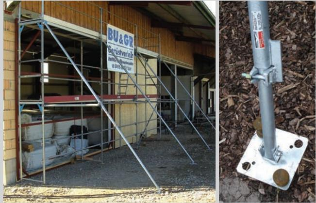
Der Anschluss der Kupplungen muss im Bereich des Knotenbleches liegen.
